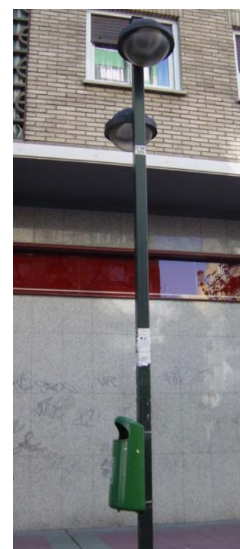
Tipología de alumbrado: báculos de un brazo y farolas de dos brazos
