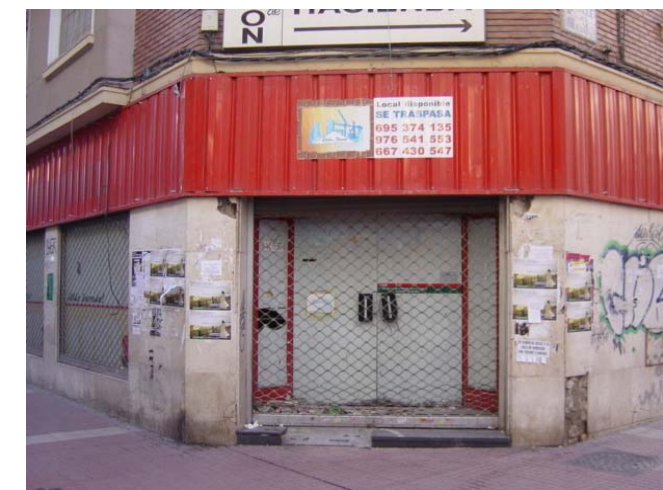
Algunos locales en desuso, deterioran la imagen del conjunto comercial
