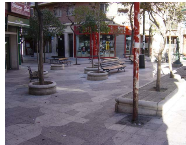
Deterioro de las zonas de descanso, mobiliario, pavimentos, etc...(Plaza Huesca)
