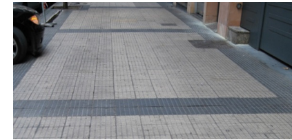
Pavimento baldosa bicromático blanco-negro formando cuadros. Estado de conservación medio de aceras y calzada. Deficiente estado de la pintura vial.
