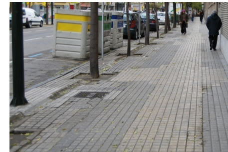
Canal de recogida de aguas entre alcorques.
