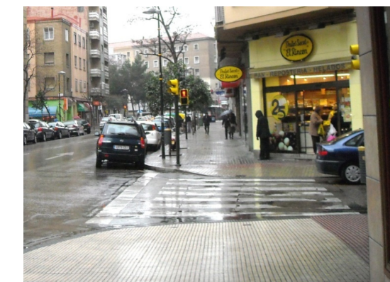
Bordillos rebajados en aceras junto a pasos de peatones para mejora de la accesibilidad.
