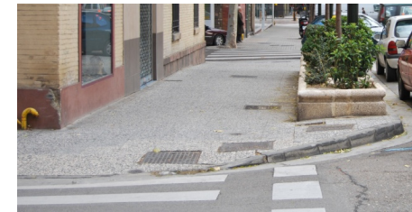
Diferentes pavimentos según tramos: terrazo y baldosa hidráulica en estado de conservación deficiente.
