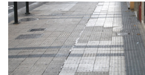
Pavimentos de baldosa de diferente patrón en aceras y paseo central. Estado de conservación deficiente.
