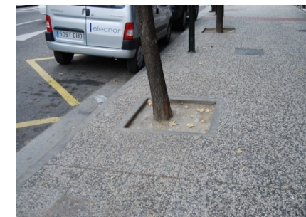
Arbolado de gran porte con alcorques sin protección.
