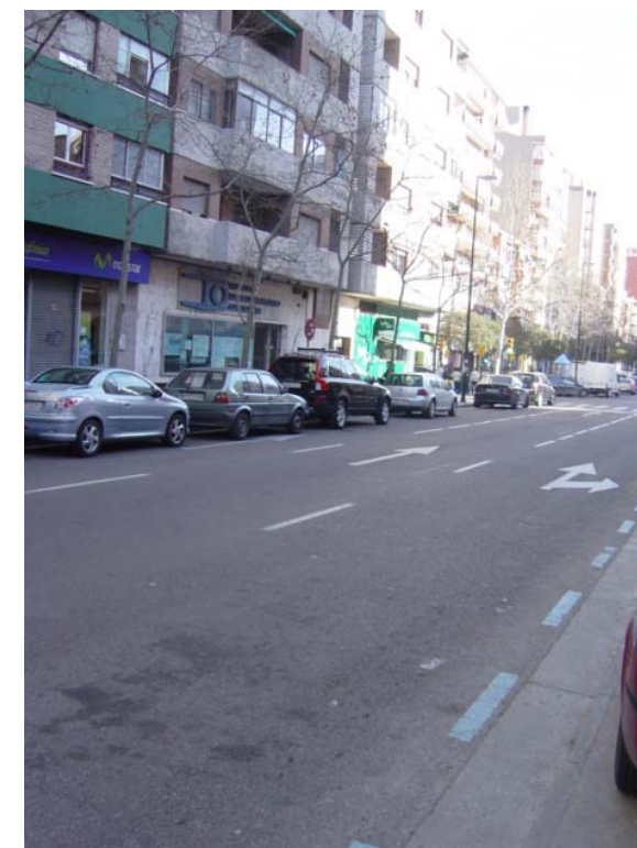
Estacionamiento regulado, ESRO. Carril izquierdo de circulación, se emplea para estacionar.
