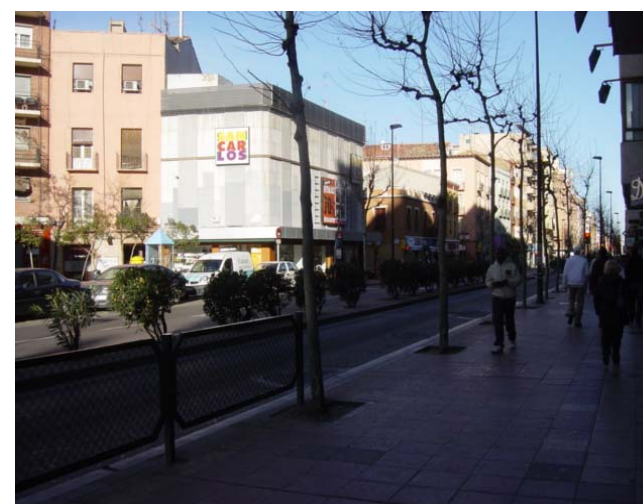
Barandillas de protección entre carril bus y aceras
