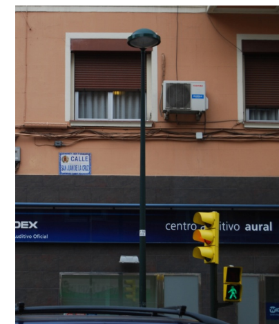
Iluminación viaria a base de farolas pareadas.
