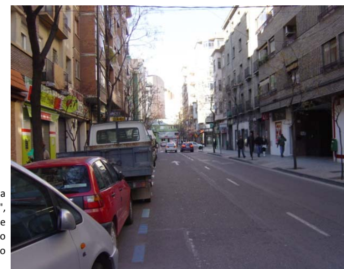
Ausencia de pasos peatonales, y presencia de arbolado en ambos lados del vial, sin protección mediante alcorques.
