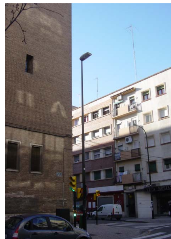
Alumbrado público inadecuado, tipo industrial, y colocado en un solo lado vial.
