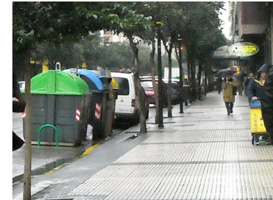
El vial presenta recogida selectiva de residuos urbanos en superficie, ocupando la banda d aparcamiento con protecciones metálicas.
