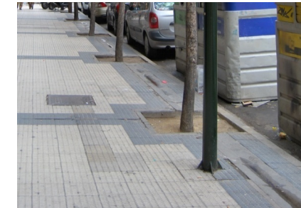
Arbolado en ambas aceras con alcorques sin protección. Canaleta continua de recogida de aguas en aceras.
